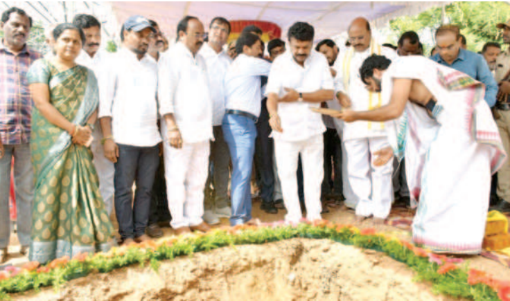
చేపల మార్కెట్ నిర్మాణ పనులకు శంకుస్థాపన చేస్తున్న మంత్రి తలసాని శ్రీనివాస్‌యాదవ్, ఎమ్మెల్యే మంచెరెడ్డి కిషన్‌రెడ్డి తదితరులు
